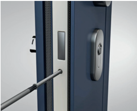
5. Entfernen Sie die Befestigungsschraube.
